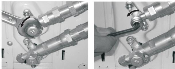
2. En vous basant sur les images ci-dessous, répétez le même processus pour la vanne inférieure. Retirez le couvercle de la vanne inférieure à l'aide d'une clé à fourche de 19 mm ou d'une clé à molette (de type réglable). Ensuite, insérez une clé Allen de 5 mm et ouvrez la vanne en la tournant dans le sens inverse des aiguilles d'une montre le plus possible. **NE PAS forcer.** Revissez le couvercle sur la vanne inférieure et serrez bien pour vous assurer qu'il est bien scellé.
