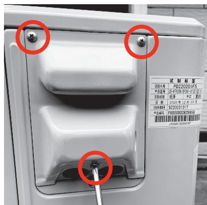
2. Retirer l'écrou de retenue de l'extrémité du DIYPRO™ câble que vous avez fait passer par le trou du mur plus tôt au cours de l'installation, comme le montre l'image ci-dessous.
