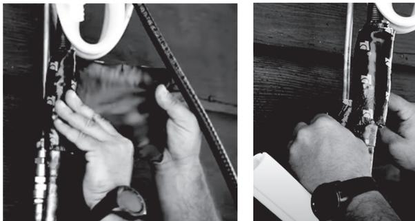
Placez ensuite le matériau d'isolation fourni sur les connecteurs et la tuyauterie de réfrigérant exposée
