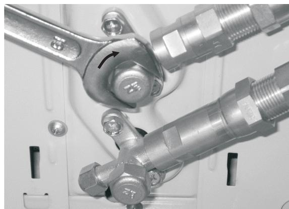
6. Retirez maintenant le couvercle de la vanne inférieure à l'aide d'une clé à molette de 19 mm (ou d'une clé ajustable). Ouvrir la vanne au maximum en la tournant dans le sens inverse des aiguilles d'une montre à l'aide d'une clé Allen de 5 mm. Si la vanne n'est pas complètement ouverte, le système risque de ne pas fonctionner correctement et de subir des dommages. Revissez le couvercle sur la vanne inférieure et bien le serrer afin de s'assurer qu'il est bien scellé.
