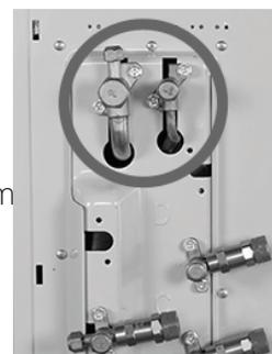
9. Démarrez l'équipement de manière à ce que les pressions de fonctionnement se mettent en place à l'intérieur du circuit. Vérifiez à nouveau tous les connecteurs pour détecter tout signe de fuite.
