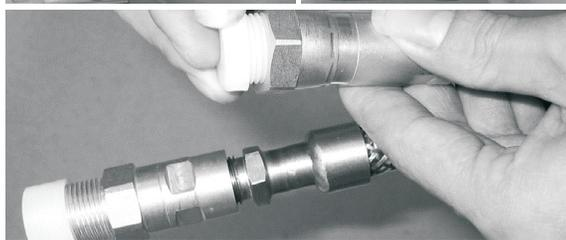
3. Alignez correctement les conduites de produit réfrigérant pour qu'elles s'alignent avec les vannes et ne soient pas soumises à des contraintes. Placez le raccord à vis sur la conduite de produit réfrigérant juste sur le filetage de l'unité extérieure et serrez les premiers filetages à la main.
