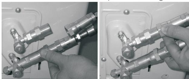
**REMARQUE :** Les conduites de réfrigérant doivent être raccordées aux vannes de l'unité extérieure avec le moins de stress possible.
