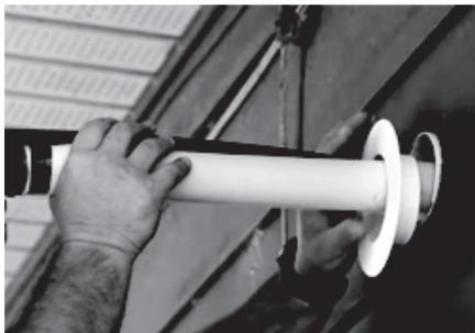
2. Placez votre main en dessous de la tuyauterie qui passe par le trou du mur extérieur (de l'unité intérieure), près du mur. À l'aide de votre autre main, en exerçant une pression régulière, pliez soigneusement le tuyau vers le bas, en direction du mur, en veillant à ne pas l'endommager ou le bosseler.
