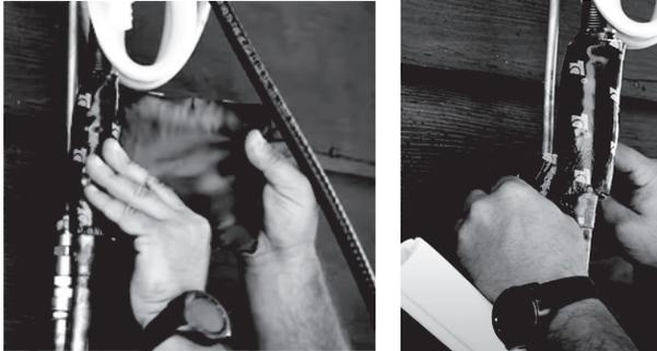
2. Placez ensuite le matériau d'isolation fourni sur les connecteurs et la tuyauterie de réfrigérant exposée
