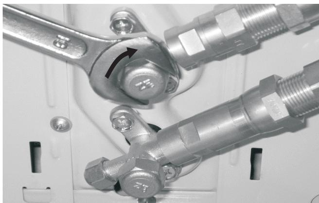
2. En vous basant sur les images ci-dessous, répétez le même processus pour la vanne inférieure. Retirez le couvercle de la vanne inférieure à l'aide d'une clé à fourche de 19 mm ou d'une clé à molette (de type réglable). Ensuite, insérez une clé Allen de 5 mm et ouvrez la vanne en la tournant dans le sens inverse des aiguilles d'une montre le plus possible. **NE PAS forcer.** Revissez le couvercle sur la vanne inférieure et serrez bien pour vous assurer qu'il est bien scellé.
